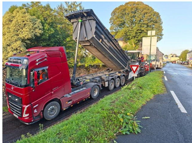
Chantier 1 : Voie Communale de « Pors Very »
